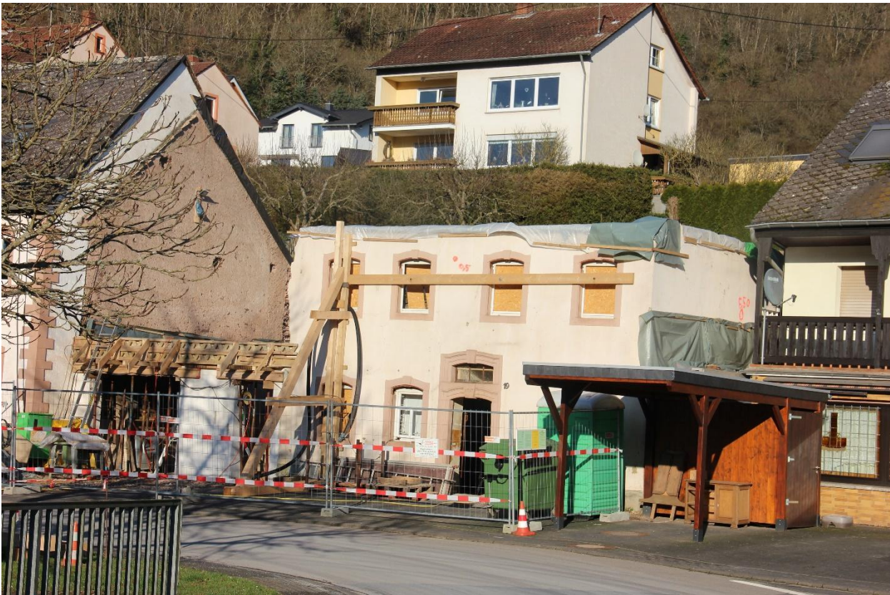
Abbildung 61 Erhalt der Fassade durch Bestimmungen des Denkmalschutzgesetzes (Aufgenommen in Bruch: 05. 02. 2018)
