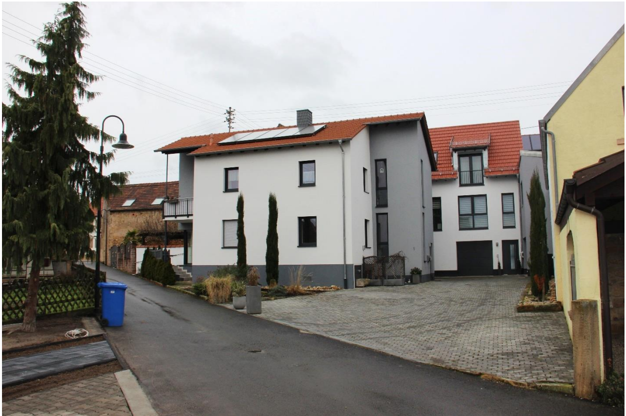
Abbildung 17 Moderne Nachverdichtung im Ortskern von Kallstadt, VG Freinsheim (Eigene Aufnahme)
