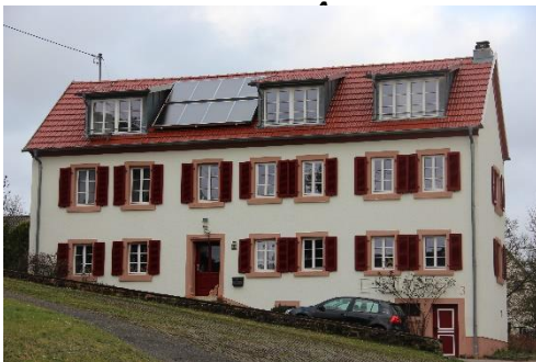
Mittels Dorferneuerung saniertes Wohngebäude
