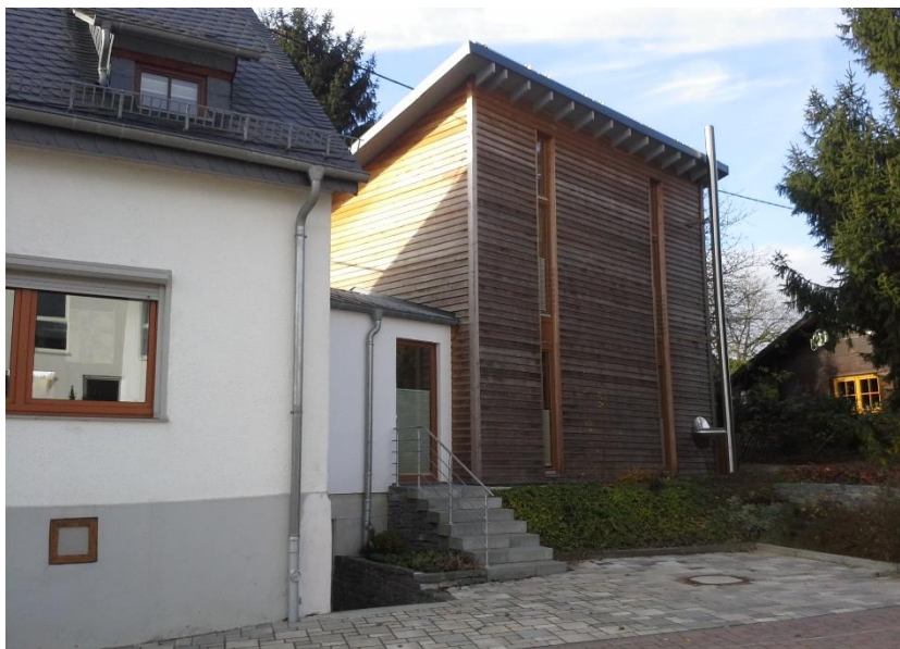
Mit Hilfe des Förderprogramms finanzierter Anbau in OG Wallmerod
