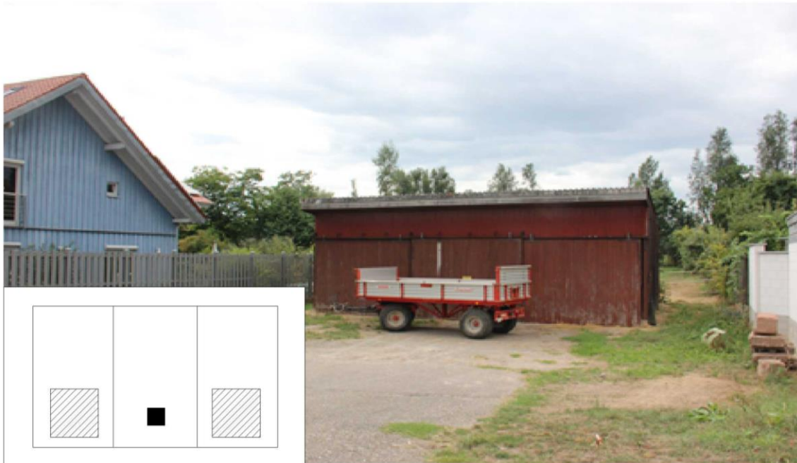
Abbildung 23 Geringfügig bebaute Baulücke in Rohrbach (Eigene Aufnahme)
