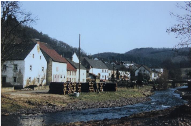
Bruch - Salmstraße vorher
