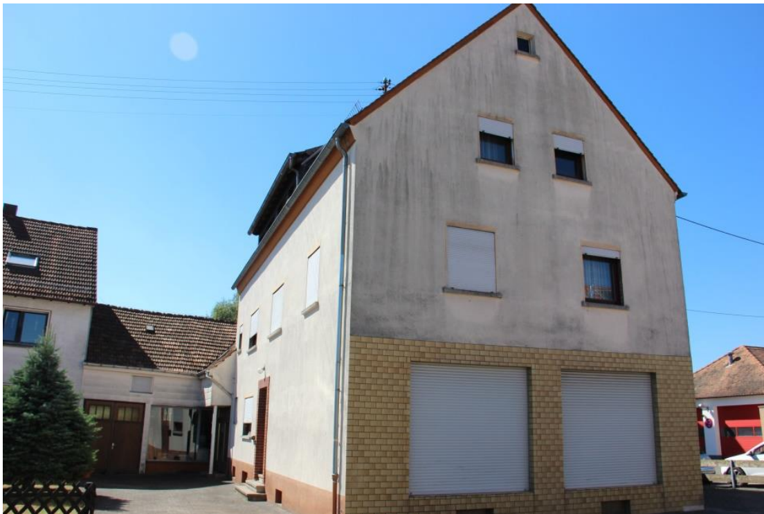
Abbildung 15 Leerstehendes Wohn- und Geschäftsgebäude in Martinshöhe (Eigene Aufnahme)
