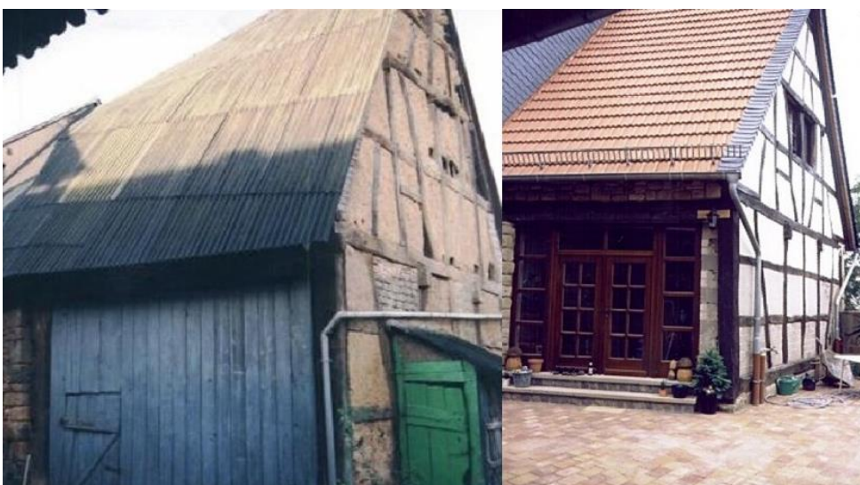
Duchroth - Dorferneuerung Vorher-Nachher-Beispiel
