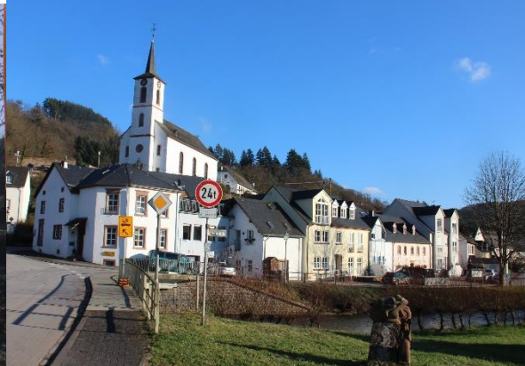
Salmstraße heute (nach den Sanierungsmaßnahmen)
