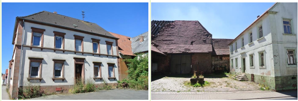
Abbildung 32: Problemobjekte alte Hofanlagen – Ortsgemeinde Martinshöhe
