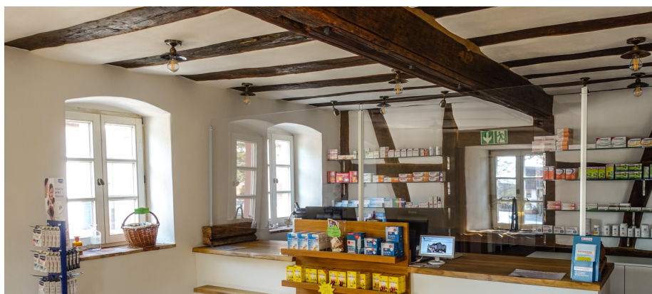
Die Deckenbalken wurden bei der Sanierung freigelegt, um die Originalität zu wahren
