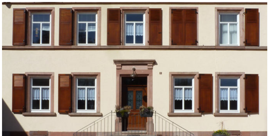
Beim Austausch der Fenster sowie dem Anbringen von Holzklappläden erhielten die Bauherren dieses Gebäudes in Kottweiler-Schanden ebenfalls Unterstützung aus Mitteln des Dorferneuerungsprogramms
