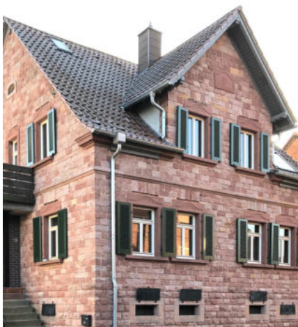
Die Sanierung dieses Wohnhauses in Mackenbach wurde von der Dorferneuerung unterstützt
